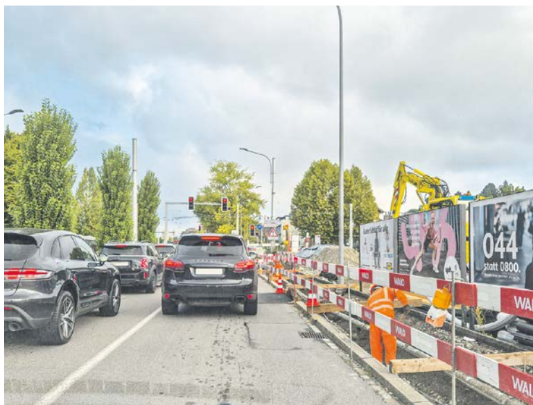
Baustelle des EWZ am Tiefenbrunnen zur Erschliessung des SBB-Gewerbeneubaus. (Bild: cef)
