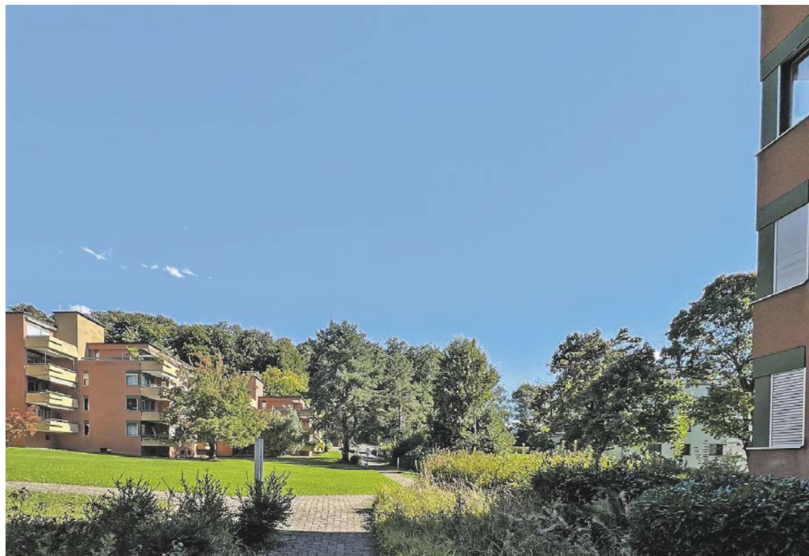
Die von der Leerkündigung betroffenen Häuser an der Oberen Bühlstrasse. (Bild: zvg)
