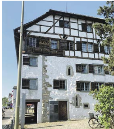
Das Höchhus vor der Sanierung. (Bild: zvg)
