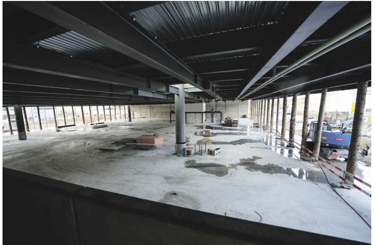
Umbau auf dem Gelände einer ehemaligen Druckerei: In Zukunft wird die Mehrheit der Küsnachter Buslinien von der neuen Busgarage in Oetwil am See starten. (Bild: jli)
