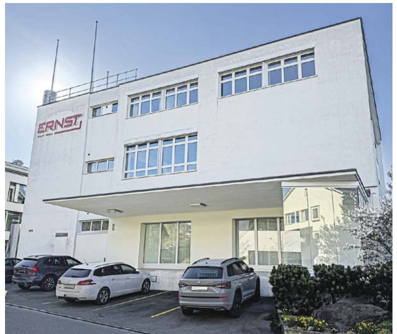
Soll bald eine Schuleinheit für 168 Schülerinnen und Schüler werden: Das Erdgeschoss des Gebäudes auf dem Areal Ernst, in dem jetzt noch eine Bank residiert. (Bild: dwe)
